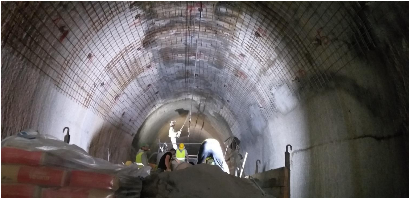
Izrada prskanog betona u sklopu ojačanja kalote
