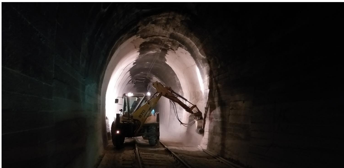
Frezanje- štemanje površinski ruiniranog betona
