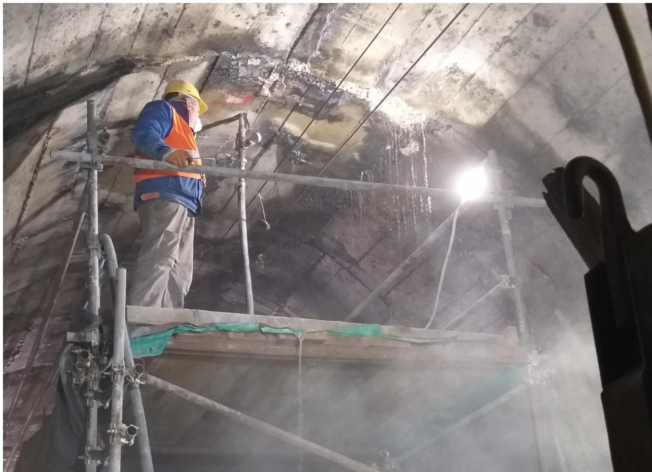
Kontaktno injektiranje
