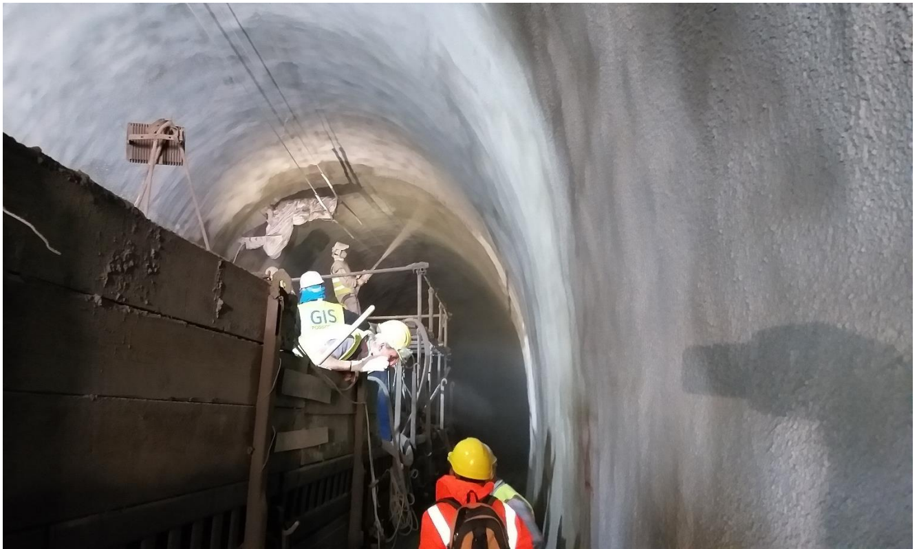
Izrada završnog sloja prskanog betona u sklopu zaštite čepaste folije ( konačni izgled obloge tunela )
