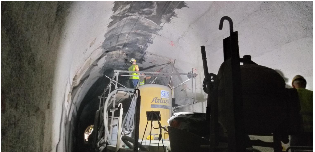
Ugrađivanje IBO ankera
