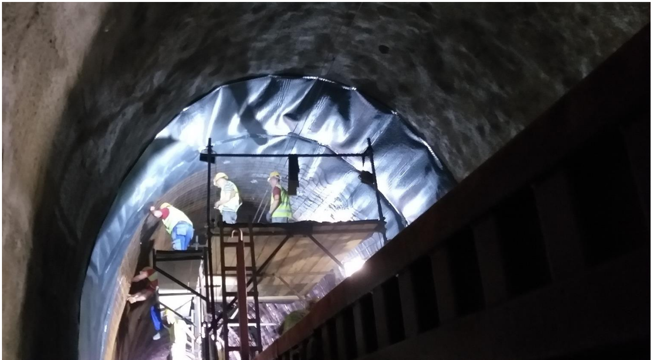
Postavljanje hidroizolacione čepaste folije i mreža u sklopu zaštite čepaste folije
