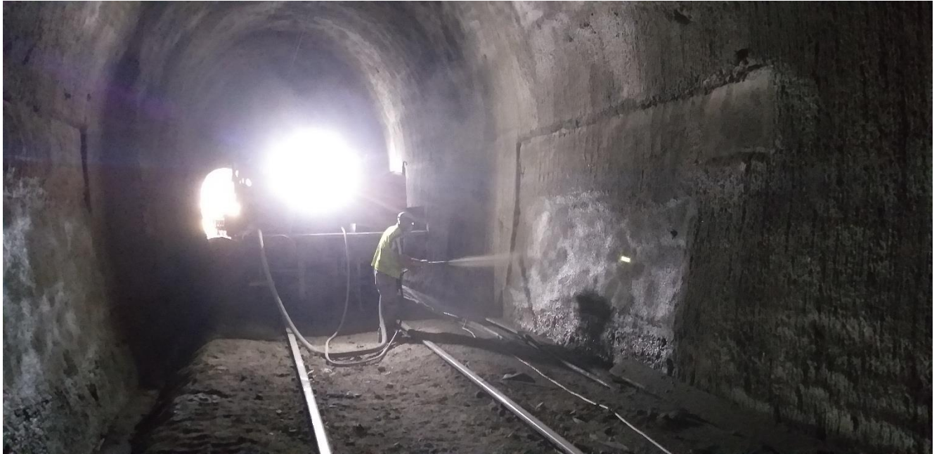
Ugrađivanje prskanog betona u plombe
