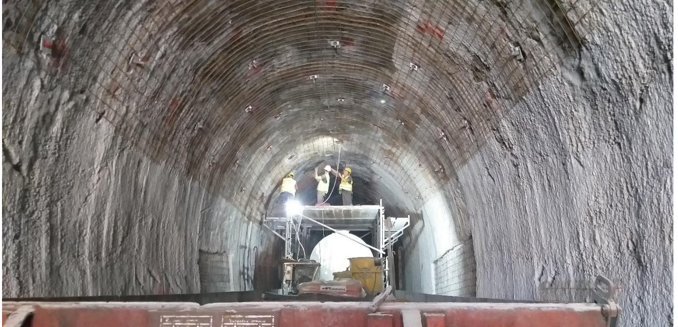
Armiranje ojačanja kalote
