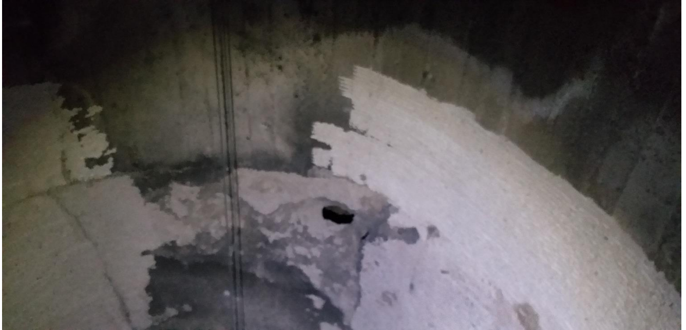
Rupa u kaloti u postojećoj oblozi tunela
