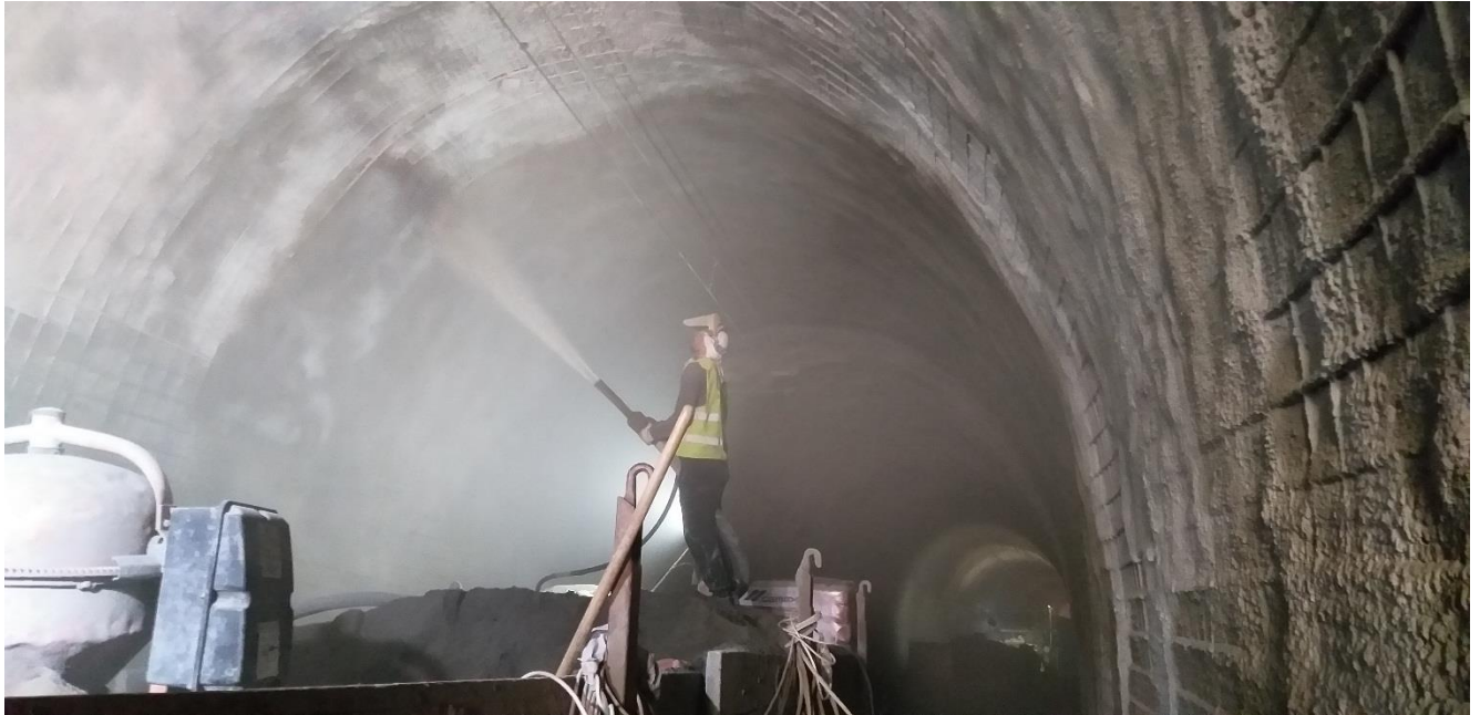
Izrada prvog sloja prskanog betona u sklopu zaštite čepaste folije
